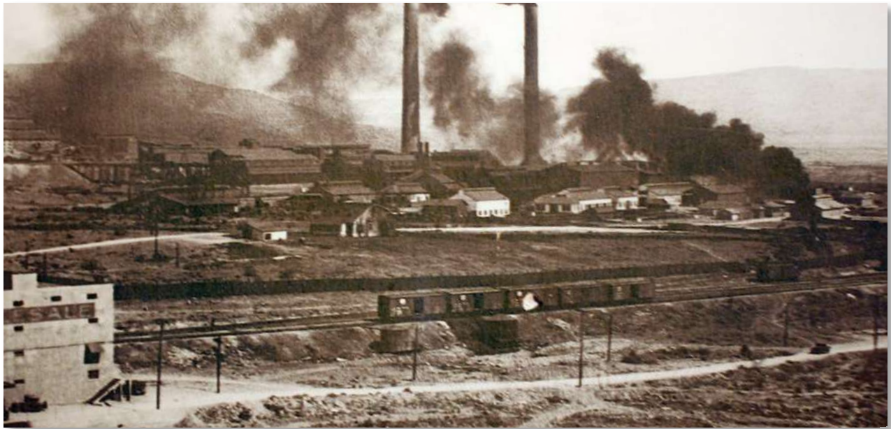
Clarkdale Smelter (Fundição de Clarkdale), por volta de 1950
